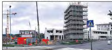
«TÅRNET»: Slik ser MacGregor-bygget ut nå når man kommer kjørende i rundkjøringen i Barbu. På dette 22 m høye tårnet skal det henges en i alt 50 meter lang stålkonstruksjon.
