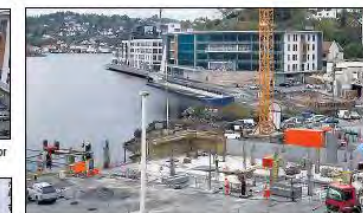
BOLIGBLOKKER: Nærmest ser vi fundament og p-kjeller for de to første av tre boligblokker. En blokk bygges ut over pælene i sjoen.
