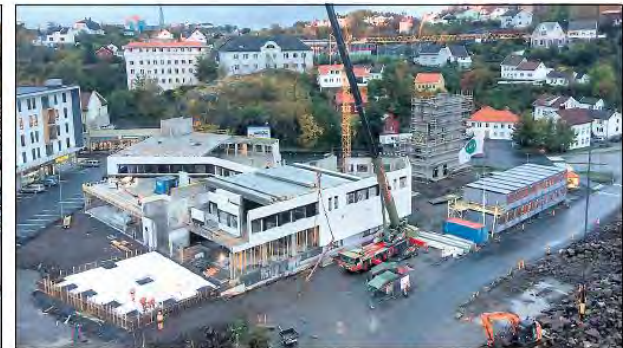
MACGREGOR-KONTORBYGGET: Nybygget på 7.751 kvm settes opp for en stor del av prefabrikerte elementer. Her byggeplassen fotografert fra toppen av en av de svære kranene. FOTO: JBU
