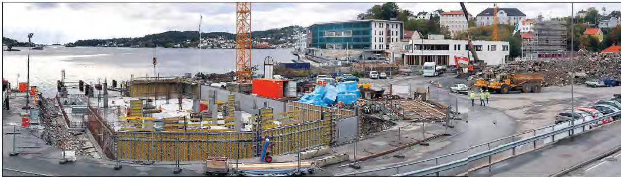
HEKTISK BYGGING I BARBU: J.B. Ugland Entreprenør og en rekke underentreprenører bygger over store deler av Barbu bukt for tiden. Til venstre ser vi fundament og p-kjeller til to av de bakgrunnen skvetter det nye, store kontorbygget som skal huse MacGregor opp i stor hastighet. Over «tårnet» vi ser helt til høyre kommer snart en svar stålkonstruksjon som i hele 50 meters
