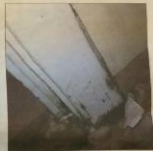
FUKTSKADER: Slik så det ut på et foyerrom på Wolla, der beboerne er et par som venter barn.
